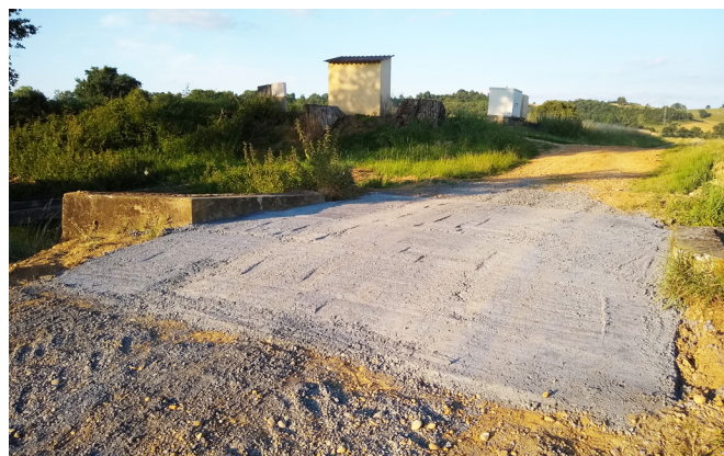
Réfection du revêtement du pont du chemin des Arrious
