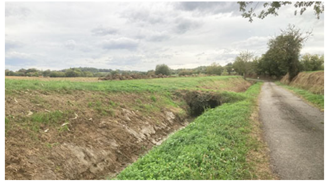
Curage du chemin des Arrious
