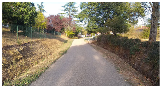
Réfection du chemin de l'église vieille
